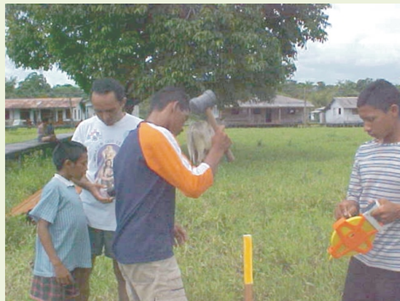
INSTALAÇÃO DO MARCO
